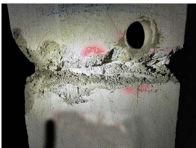
foto 29: Sonda S-11 do pilíře 1..PP s rohovou výztuží a třmeny
