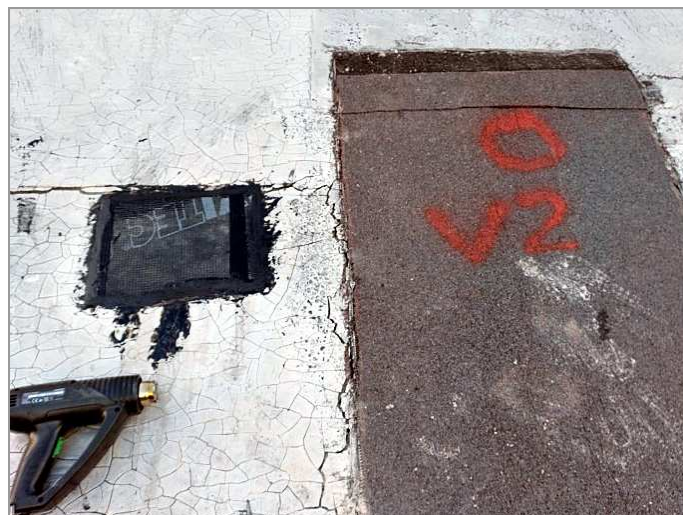
foto 40: Zpětná oprava místa vrtané sondy V-2
