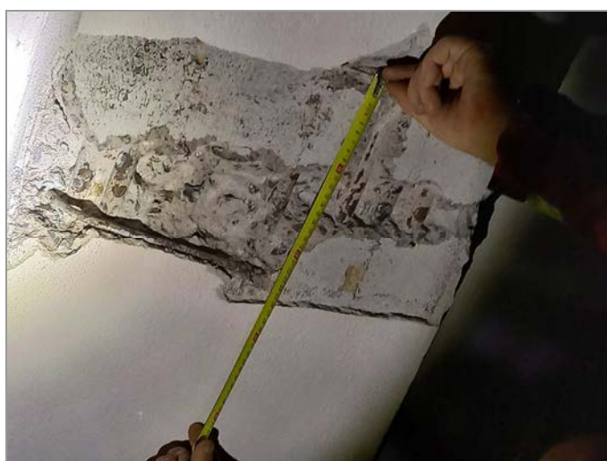
foto 10: Výztuž průvlaku v sondě S-1 stropu nad 1.PP
