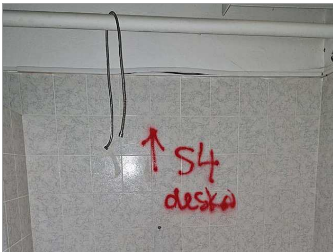
foto 19, 20: Pohled na místo plošné sondy S-4 do stropní desky nad 1.PP a detail jádrového vývrtu z desky
