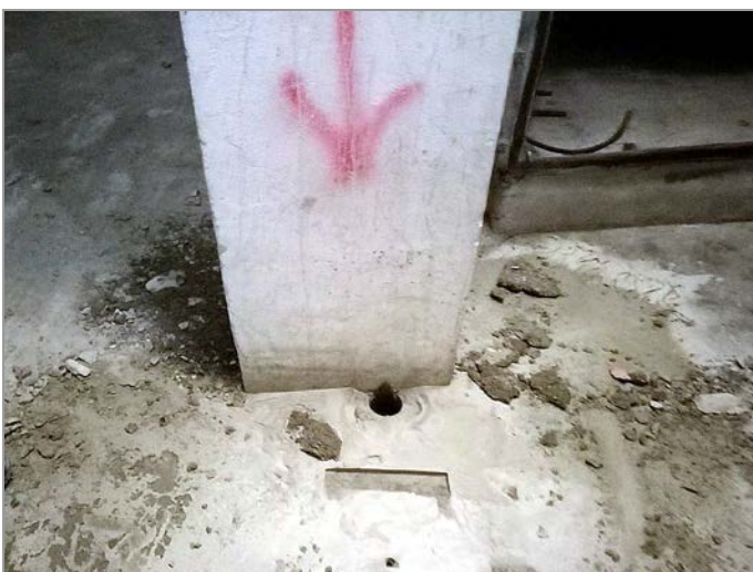
foto 15, 16: Pohled na místo vrtané průzkumné sondy S-3 do podlahy 1.PP a detail ústí vrtu
