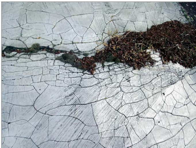
foto 61, 62: Zastřešení hlavního sálu a pódia – detail znečištěného povrchu střechy s porostem náletové vegetace
