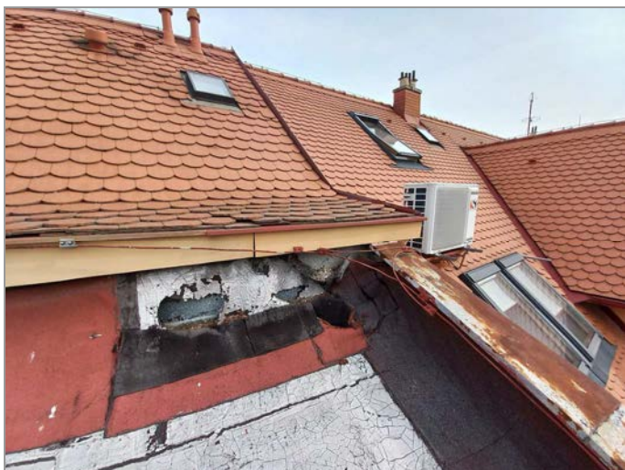
foto 53, 54: Zastřešení hlavního sálu a pódia - celkově špatný technický stav klempířských prvků a střešní krytiny
