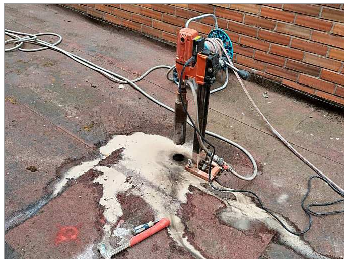
foto 43, 44: Realizace vrtané sondy V-3 do střešního pláště
