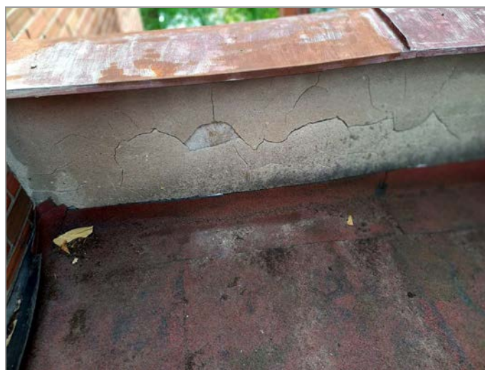
foto 65, 66: Detail střechy nad spojovací částí objektu - špatný technický stav obkladů, klempířských prvků a střešní krytiny
