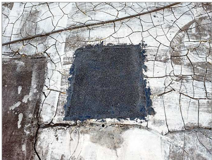
foto 36: Zpětná oprava místa vrtané sondy V-1
