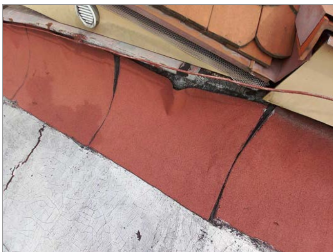
foto 55, 56: Zastřešení hlavního sálu a pódia - celkově špatný technický stav klempířských prvků a střešní krytiny
