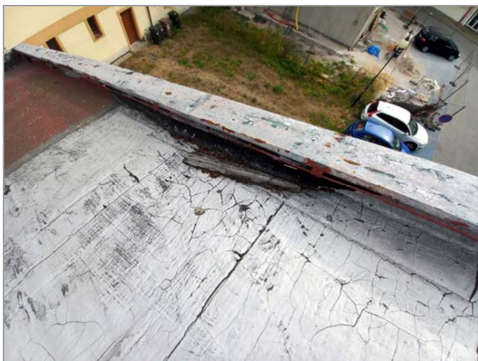
foto 59, 60: Zastřešení hlavního sálu a pódia - celkově špatný technický stav klempířských prvků a střešní krytiny
