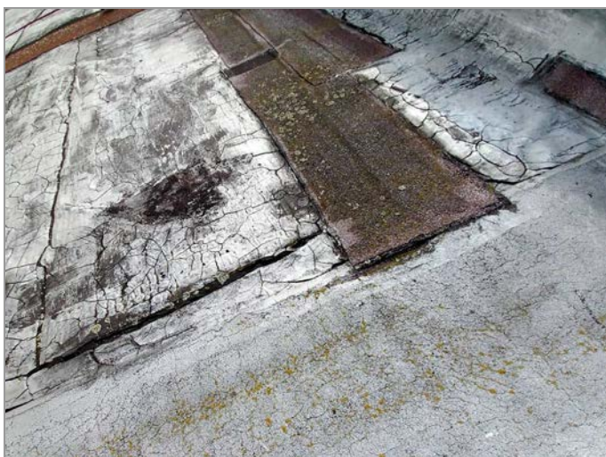
foto 57, 58: Zastřešení hlavního sálu a pódia - celkově špatný technický stav klempířských prvků a střešní krytiny
