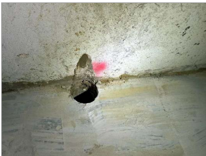
foto 13, 14: Detail ústí vrtané průzkumné sondy S-2 do podlahy 1.PP a pohled na vrtné jádro
