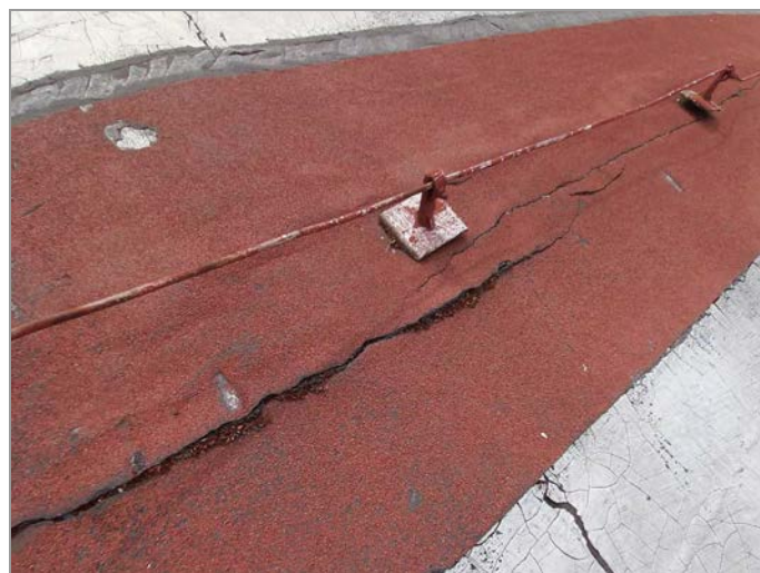
foto 55, 56: Zastřešení hlavního sálu a pódia - celkově špatný technický stav klempířských prvků a střešní krytiny
