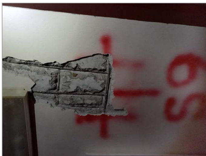
foto 25, 26: Pohled na místo plošné sondy S-9 do stropní desky nad 2.NP a detail jejího křížového vyztužení při dolním povrchu
