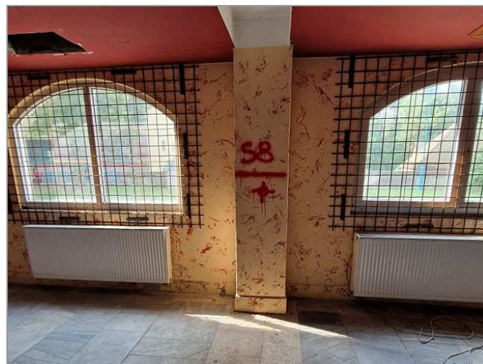
foto 23, 24: Pohled na místo sondy S-7 do průvlaku stropu nad 1.NP resp. sondy S-8 do pilíře v 1.NP
