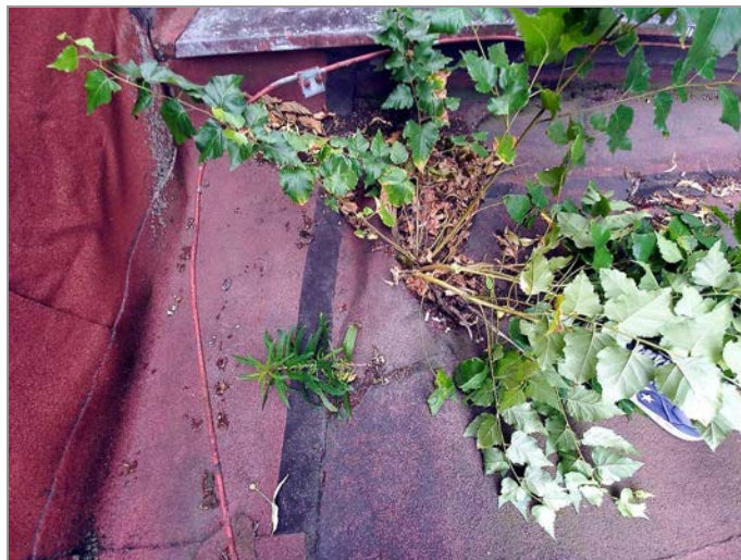
foto 61, 62: Zastřešení hlavního sálu a pódia – detail znečištěného povrchu střechy s porostem náletové vegetace
