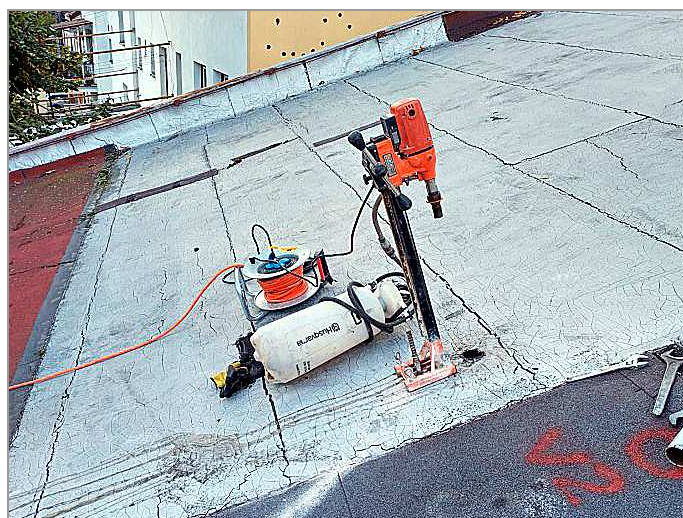
foto 38: Realizace vrtané sondy V-2 do střešního pláště
