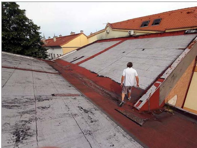
foto 49: Pohled na úžlabí mezi střechou sálu a pódia
