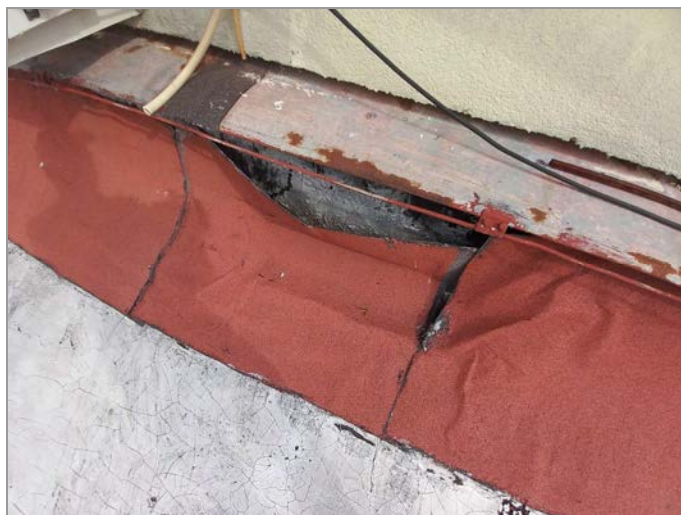
foto 53, 54: Zastřešení hlavního sálu a pódia - celkově špatný technický stav klempířských prvků a střešní krytiny
