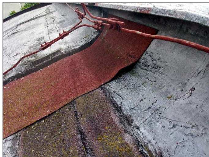
foto 57, 58: Zastřešení hlavního sálu a pódia - celkově špatný technický stav klempířských prvků a střešní krytiny
