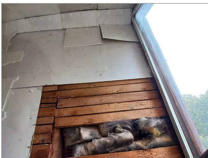
foto 30: Sonda S-12 do ostění střešního vikýře
